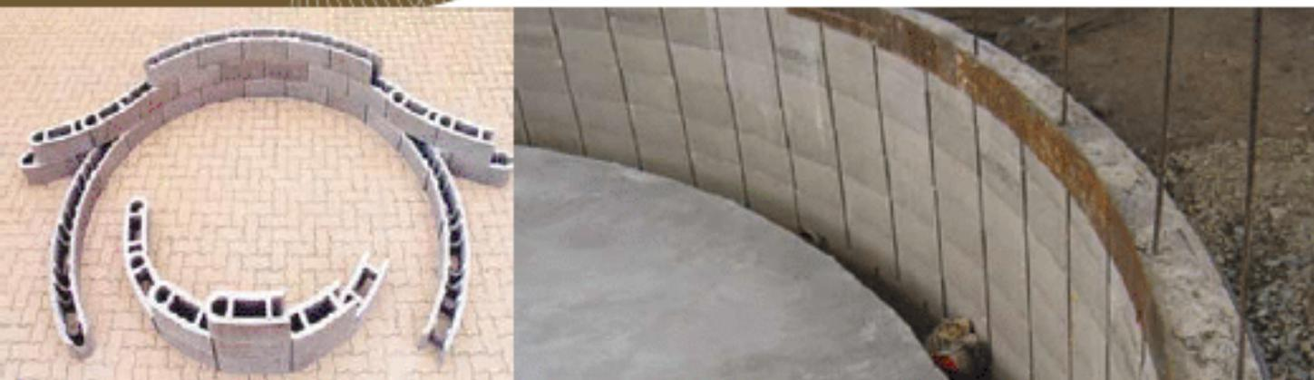
Ce bloc est un bloc de coffrage en béton de granulats courants destiné à réaliser par empilage à sec des ouvrages circulaires dont la stabilité et la solidité sont acquises par remplissage de béton et complété éventuellement d'une armature de renfort.
