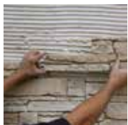
1 - Je pose en suivant le procédé IDEAPOSE et le calepinage
