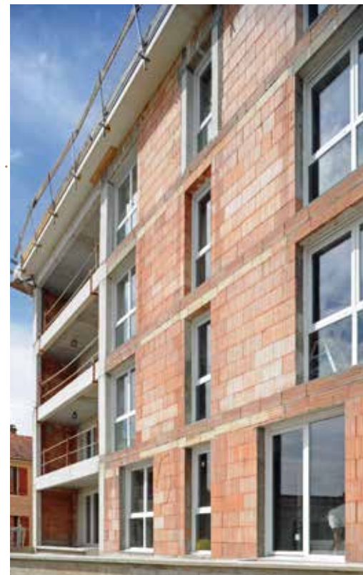
Linteau-chaînage complémentaire T20 x 19 Réserve L150 x H120 mm
