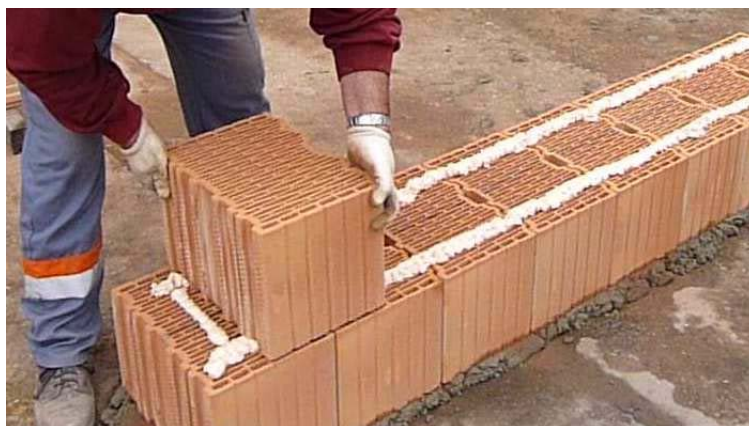
Figure 9– Pose du 1 er rang de briques (épaisseur 37,5 cm).
