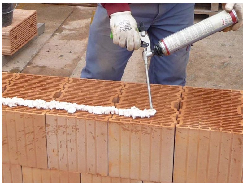
Figure 10– Application du DRYFIX® sur des briques d'épaisseur 37 cm.
