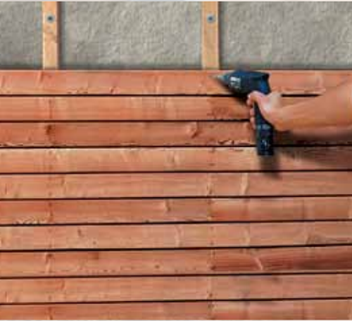
Montage du revêtement de surface
