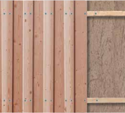
Montage du revêtement de surface
