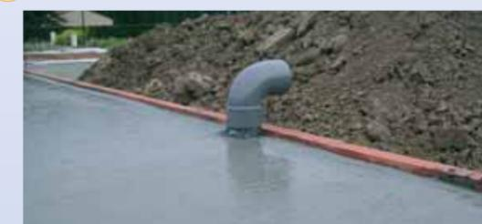
Si vous ne l'avez pas fait avant le coulage : **retirer les 2 protections du conduit de ventilation** et emboîter fermement une sortie (tube plastique coudé) de diamètre 100 mm (côté femelle vers l'Aéro VS).
