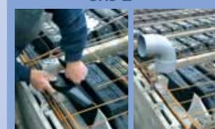
Retirer les protections du conduit de ventilation et emboîter fermement une sortie de diamètre 100 mm (côté femelle vers l'Aéro VS).
