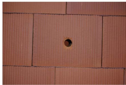
Figure 13 Fixation des éléments de sécurité
