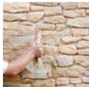
2 - Je réalise les joints
