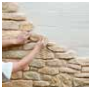
1 - Je pose en croisant les joints d'une rangée sur l'autre
