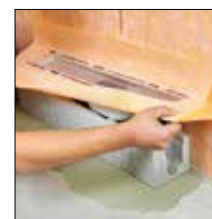
=> 2. Mettre en place le corps de caniveau
