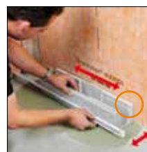
=> 1. Ajuster le support de caniveau
