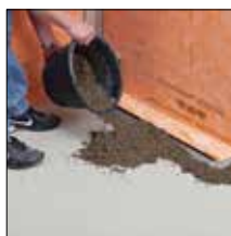
=> 5. Réaliser la chape avec forme de pente
