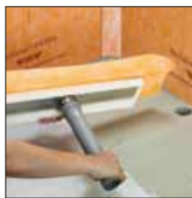
=> 2. Mettre en place le tuyau d'évacuation
