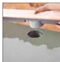
=> 4. Placer le corps de caniveau avec son support
