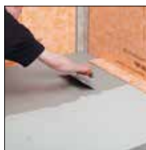
=> 6. Déposer du mortier-colle
