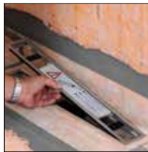
=> 1. Mettre en place le cadre avec les blocs en polystyrène pour maintenir son écartement
