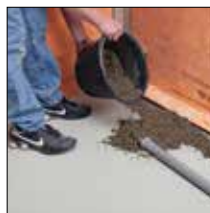
=> 6. Réaliser la chape avec forme de pente
