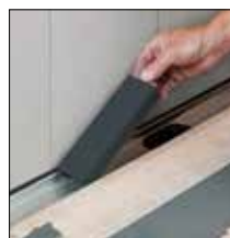
=> 2. Mettre en place le gabarit de pose dans le corps du caniveau
