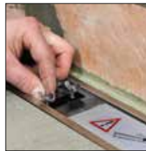
=> 2. Régler la hauteur du cadre à l'aide des cales et des vis papillon...
