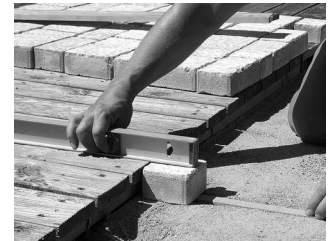
Vérifier la parfaite planéité du support lors de la pose des premiers pavés.
