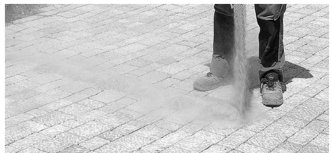
Utiliser un sable fin versé directement sur la surface pavée.
