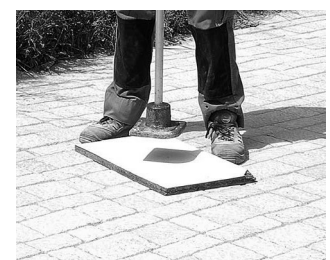
Compacter en utilisant une plaque protégée par un feutre.
