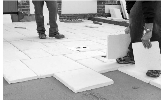
Mise en place des dallages (ici des dalles Castellane multiformat) sur lit de sable parfaitement de niveau.
