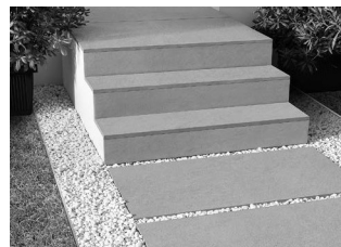
Pose sur gravillon.
