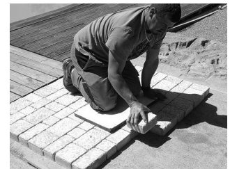
Déplacez-vous à l'aide d'une planche sur les pavés déjà posés.
