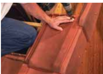
Fixation des tuiles en rives latérales gauche et droite par vis et rondelles d'étanchéité.
