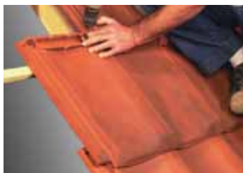
Fixation des tuiles en plain carré pour tenue à forte pente, par vis et rondelles d'étanchéité.
