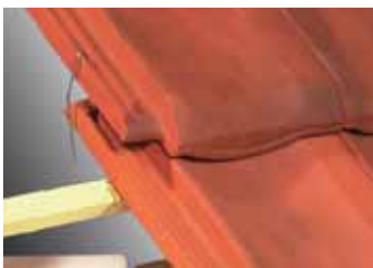
Fixation des tuiles en plain carré pour tenue au vent par crochet Mono H10.
