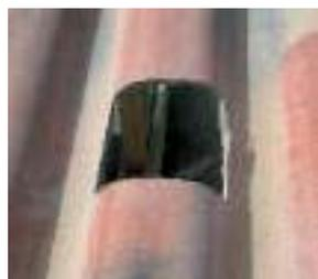
2 ► Position du trou sur la 3<sup>ème</sup> onde de la Soutuile 230 de dimensions 20 x 20 cm pour le passage de la VMC.
