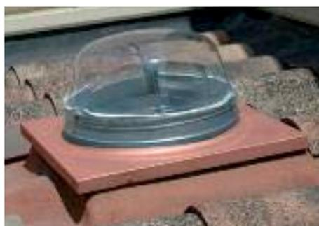
4 ► Installer le dôme avec son tube de départ sur l'embase, orienter la membrane prismatique plein sud et fixer à l'embase à l'aide de vis (fournies avec le puits de lumière).
