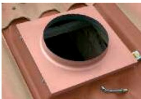
3 ► Installation de l'embase métallique fixée à l'aide de boulons TR8. Un joint d'étanchéité à l'air doit être réalisé avec une colle PU entre la plaque à châssis et l'embase métallique.
