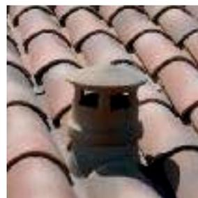
3 ► Pose de la lanterne terre cuite (Ø 150 - 180 mm intérieur) avec un joint de colle polyuréthane (type Sikaflex 11FC).
