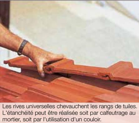
Les rives universelles chevauchent les rangs de tuiles. L'étanchéité peut être réalisée soit par calfeutrage au mortier, soit par l'utilisation d'un couloir.
