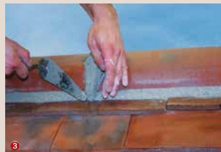
① Un lit de mortier bâtard est disposé sur les tuiles courtes de sous-faîtage qui auront été mouillées. L'about est posé avec une pression sur le mortier bâtard. ② Les faîtières suivantes sont posées de la même façon que l'about et alignées. Le jour entre les deux pièces sera d'au moins 1 cm pour que le mortier bâtard ait un ancrage. ③ Le surplus de mortier bâtard sera éliminé. Une emboîture fera le joint entre les faîtières.
