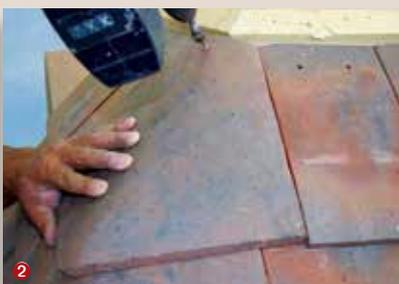
❶ Les liteaux doivent être alignés et jointifs à l'arête. Les tuiles de doublis sont tranchées en approche et le premier arêtier imbriqué vient les recouvrir. ❷ Chaque arêtier est fixé et les tuiles entières viennent se poser de part et d'autre.
