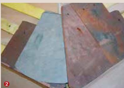
❶ Les liteaux des 2 versants doivent être jointifs et alignés à l'axe de l'arêtier. Un noquet sera placé sur le rang d'égout, un pliage en tête permettra de l'accrocher au liteau. ❷ Les tuiles d'approche sont tranchées en biais de façon à fermer l'arête. L'utilisation de tuiles et demie permet une fixation plus aisée et la pose à joints croisés est facilitée.
