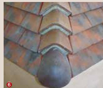
❸ Les tuiles d'approche auront toutes la même découpe ; les joints croisés des rangs seront par conséquent respectés et réguliers. ❹ Les arêtiers recouvrent les tuiles d'environ 1 à 2 cm en latéral sur la partie recouvrement. ❺ Les ouvertures entre les arêtiers peuvent être calfeutrées au mortier bâtard. ❻ Arêtier encastré terminé.
