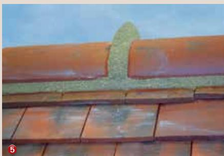
④ Le mortier bâtard de l'emboîture sera façonné selon l'esthétique recherchée. Un gabarit métallique mouillé peut être utilisé. ⑤ Le nettoyage se fait avec une éponge, ce qui permet également de lisser le mortier bâtard (après la prise).
