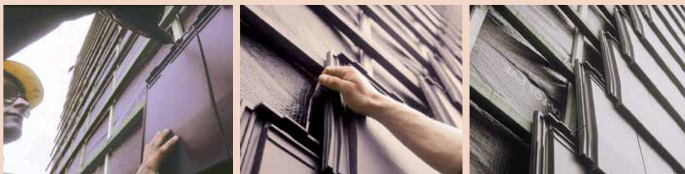
**ATTENTION :** Sélectionner le crochet de pannetonnage Koramic en fonction de la section du liteau. La fixation s'effectue avec des vis inox 4,5 x 60 mm + un anneau EPDM<sup>(1)</sup>, et le crochet latéral en inox AISI 304<sup>(2)</sup> est invisible.
