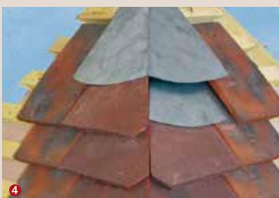
❸ Un noquet sera placé à chaque rang et toutes les tuiles (ou tuiles et demie) d'approche seront fixées. ❹ En écornant les tuiles et demie au niveau de l'arête, l'esthétique est encore améliorée et l'étanchéité renforcée.
