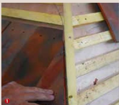
1 Les tuiles d'approche sont coupées en fonction de la largeur de l'arêtier qui vient les recouvrir. 2 Elles sont toutes fixées le long du bois de l'arête.
