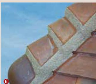
❸ Tous les arêtiers sont attachés et ensuite décalés de la ligne d'arête pour pouvoir mettre en place le mortier bâtard. ❹ Le lit de mortier disposé, l'arêtier est remis en place en exerçant une pression pour «fermer» l'ensemble. ❺ Le surplus de mortier bâtard est retiré, les ouvertures entre les arêtiers sont également calfeutrées au mortier bâtard. L'ensemble est lissé et nettoyé. ❻ Le mortier bâtard peut être teinté suivant la finition recherchée.
