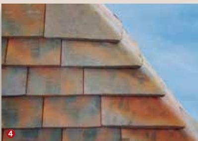
❸ Les tuiles se posent automatiquement à joints croisés. ❹ Arêtier imbriqué terminé.
