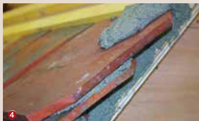
❸ Chaque tuile, tuile et demie est reposée avec une pression sur le mortier bâtard. ❹ L'espace entre les tuiles de rives et le pignon sera calfeutré au mortier bâtard.
