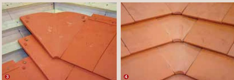
3 Les tuiles situées de part et d'autre de la tuile de noue doivent également être fixées. 4 Noue imbriquée terminée.
