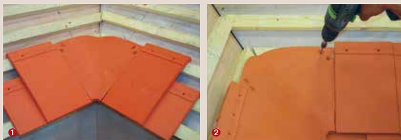
1 La première "tuile de noue" vient se placer sur le rang de doublis à l'égout. 2 Chaque tuile de noue doit être fixée et alignée en partie basse avec le nez des tuiles.
