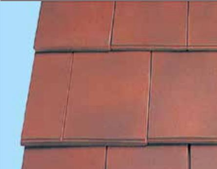
**Bord gauche** : intercaler un rang sur deux, une tuile et demie de bord gauche avec une tuile de bord gauche.
