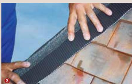
3 Le closoir sera alors déroulé à l'axe de l'arête et moulé sur le profil des tuiles. 4 L'about d'arêtier et les arêtiers seront à leur tour fixés sur le bois d'arête (vis ou clous). 5 Arêtier à sec terminé.
