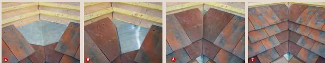
4 5 Le deuxième noquet sera, lui, adapté de façon à être masqué par le deuxième rang de tuiles. Il sera soit fixé, soit accroché au liteau (prévoir le pli). 6 Les tuiles de remplissage de part et d'autre de la noue seront adaptées en fonction du rattrapage des joints croisés avec le reste du plain carré. 7 Noue fermée avec noquets terminée.
