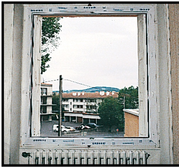
2. Positionner la menuiserie d'aplomb et de niveau après avoir préparé le dormant.
