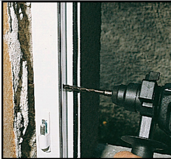
2. Percer un trou \varnothing 8 mm dans le mur au travers de la menuiserie
