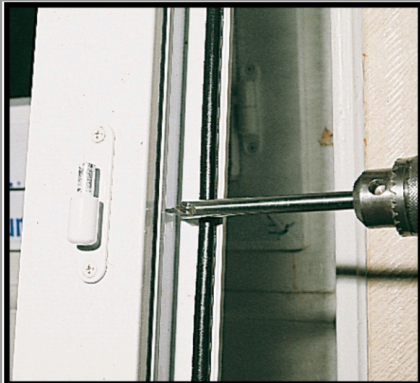
1. Percer la menuiserie au \varnothing 8,5 à 9 mm
