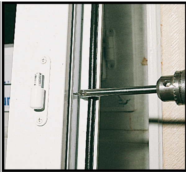
1. Percer la menuiserie au \varnothing 8,5 à 9 mm
