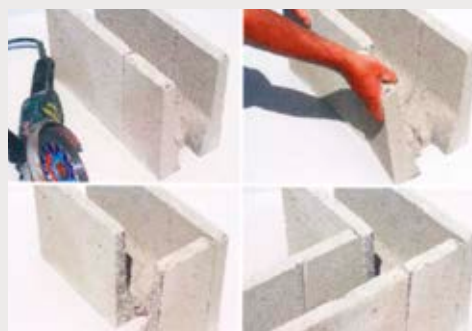
Réalisation des angles avec les blocs chaînage
