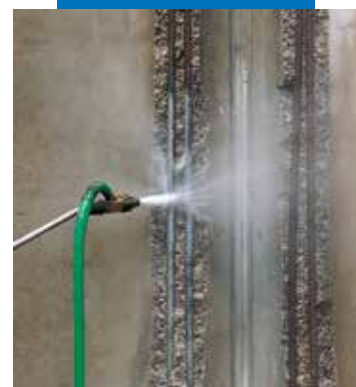
Décapage des fers par hydrosablage
