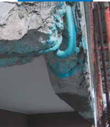
Armatures d'un nez de balcon traitées avec Mapefer 1K
