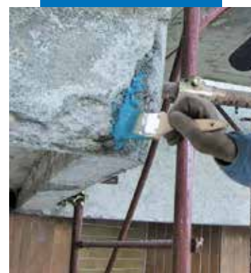
Application au pinceau de Mapefer 1K sur des armatures de balcon en béton armé
