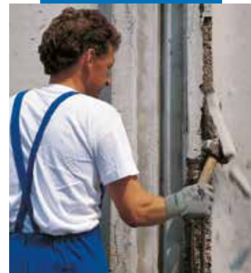
Démolition du béton dégradé
