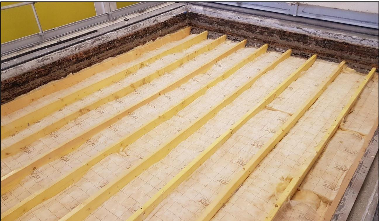
Mise en œuvre de l'isolant fibreux
