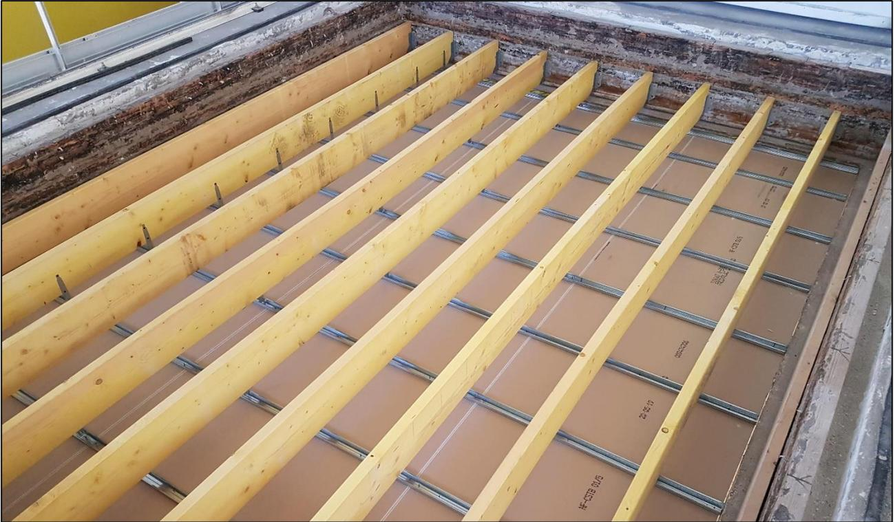
Mise en œuvre de la structure porteuse et du plafond suspendu
