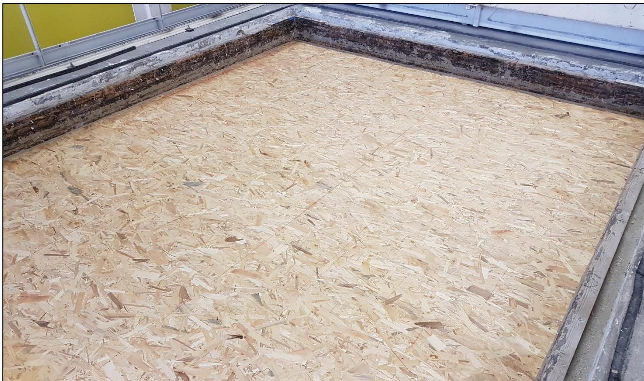
Mise en œuvre du plancher en OSB
