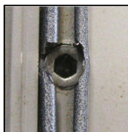
3. Vis Top-Roc mise en place.
