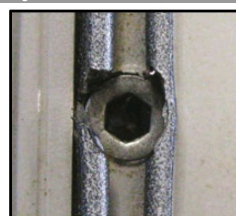
4. Vis Top-Roc mise en place.
