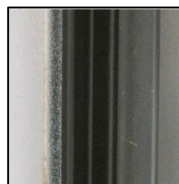
4. Joint de finition mis en place.
