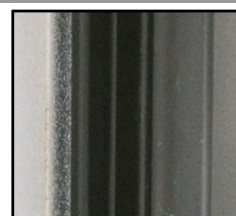
5. joint de finition mis en place.
