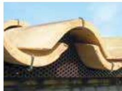
Grille métallique bas de versant T 235
