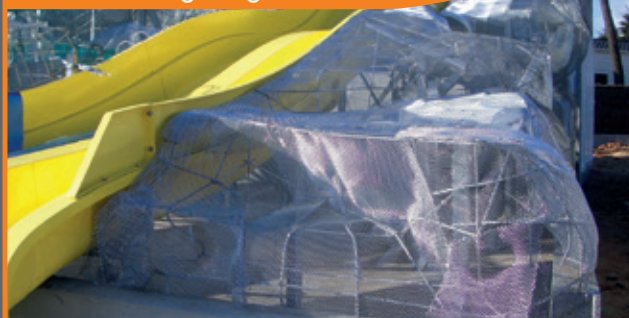
1. Pose du grillage
