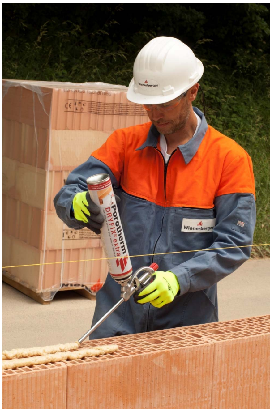
Figure 10 – Assemblage au DRYFIX
