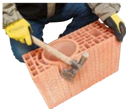
Séparation des 2 éléments du Poteau tableau multi-angles.
