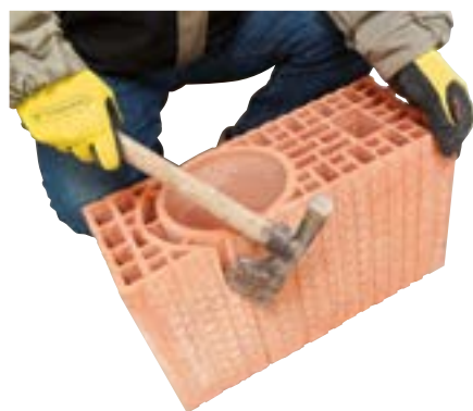
Séparation des 2 éléments du Poteau tableau multi-angles.
