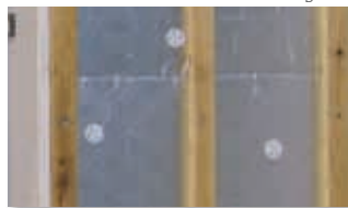
► Fixation isolant par chevilles à frapper ou chevilles clou (minimum 2 par panneau).
