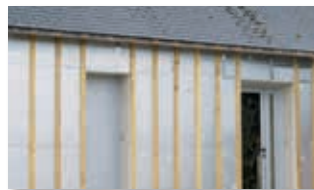
► Les tasseaux de l'ossature bois sont fixés selon un entraxe de 600 mm maximum.
