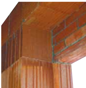
Lindeau pour volet roulant monobloc avec brique Feuillure 12.
