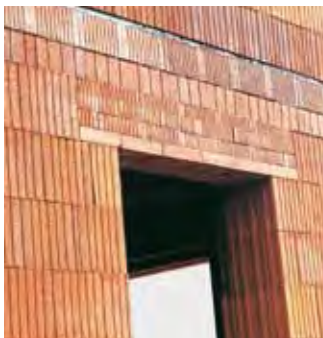
Lindeau avec prélindeau et briques de compensation.
