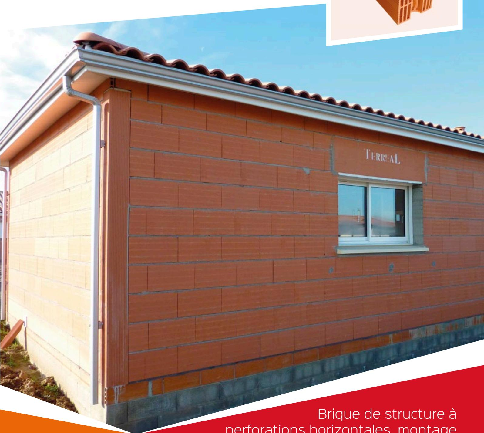
Brique de structure à perforations horizontales, montage au mortier traditionnel
