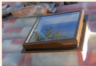
Pose de la fenêtre de toit
