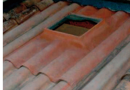
2 ► Mise en place de la plaque châssis.
