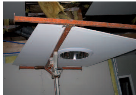
6 ► Découper le plafond et placer le diffuseur. Ensuite, emboîter le tube d'arrivée au conduit.
