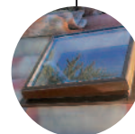
A Châssis de toit sur plaque châssis
