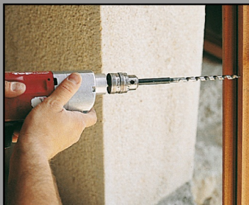
1. Percer la menuiserie au Ø8 mm
