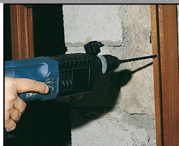
2. Percer un trou Ø8 mm dans le mur au travers de la menuiserie
