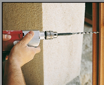
1. Percer la menuiserie au Ø8 mm
