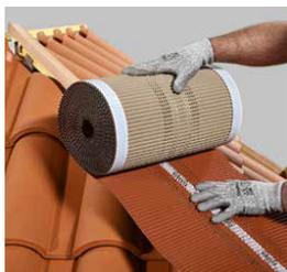
**1.** Démarrer la pose du closoir souple par l'extrémité basse de la lisse d'arêtier (pour le faîtage, commencer par l'extrémité opposée au sens des vents dominants). Bien centrer le closoir sur la lisse. Le dernier rang de tuiles doit se trouver à une distance de 1 cm de la lisse ou bois de rehausse.
