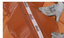
En cas de fort galbe, étirer la bavette avant de maroufler afin d'obtenir l'adaptabilité maximum du closoir. Le butyle doit être en contact avec la tuile sur toute sa longueur et toute sa largeur. Les bavettes doivent recouvrir la tuile de 10 cm (ou 8 cm en creux d'onde pour les tuiles galbées).
