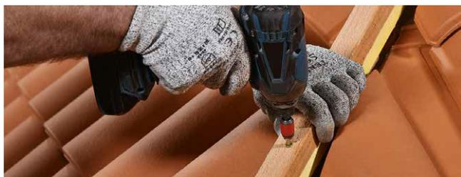
La pose des closoirs en arêtier est réalisée avant celle en faîtage. Le closoir de faîtage devra recouvrir celui de l'arêtier sur toute sa largeur. Le closoir doit être adapté à la tuile sur laquelle il sera posé (classe G0, G1, G2 ou G3).
