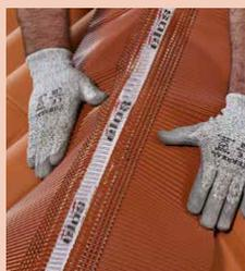
Plier le closoir sur les tuiles en se servant des plis préformés et comprimer la bavette uniformément dans le courant des tuiles des 2 côtés de la rehausse. Veiller à ne pas trop presser la partie centrale perforée sur la rehausse afin de ne pas diminuer la capacité de ventilation.
