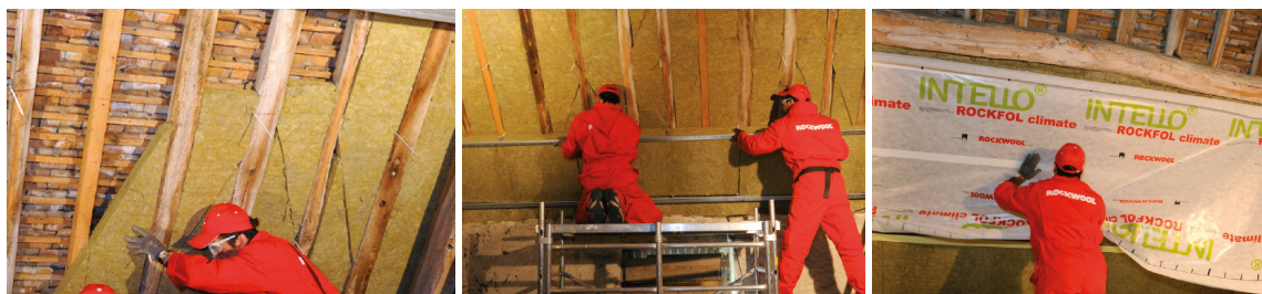
1 Pose de la première couche d'isolant
