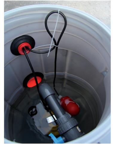
Régler le débattement du régulateur en faisant coulisser le câble dans les colliers. (voir image ci-jointe)
