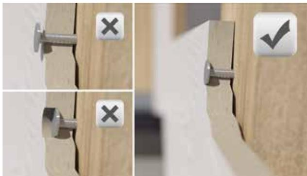
Fixez le revêtement de bardage HardiePlank® avec un clou ou une vis par latte verticale. Le centre du clou / de la vis doit se situer à environ 25 mm sous le haut de la planche. La distance au bord de la planche doit être  $\geq 15$  mm.
