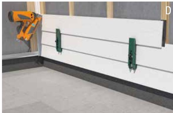
D : Rivetage ou vissage (pré-perçage inutile)
